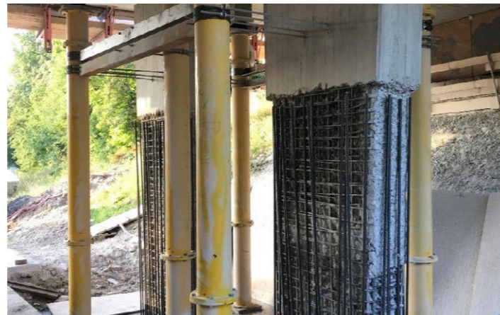
▲ Lastabfangung für HDW-Abtrag
