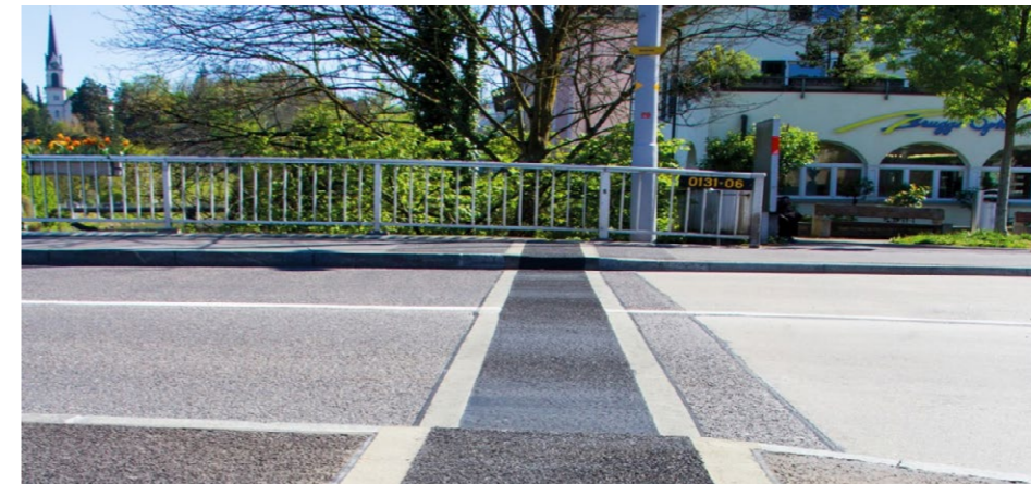
▼ Einzellige Fuge in Polymerbeton verlegt
