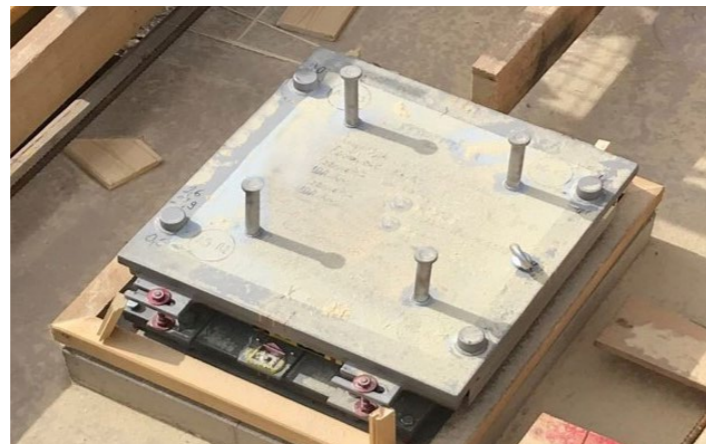
▲ Lastabfangung für HDW-Abtrag
