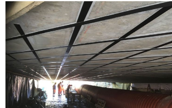
▲ CFK-Lamellen, Steinachbrücke, Nürtingen
