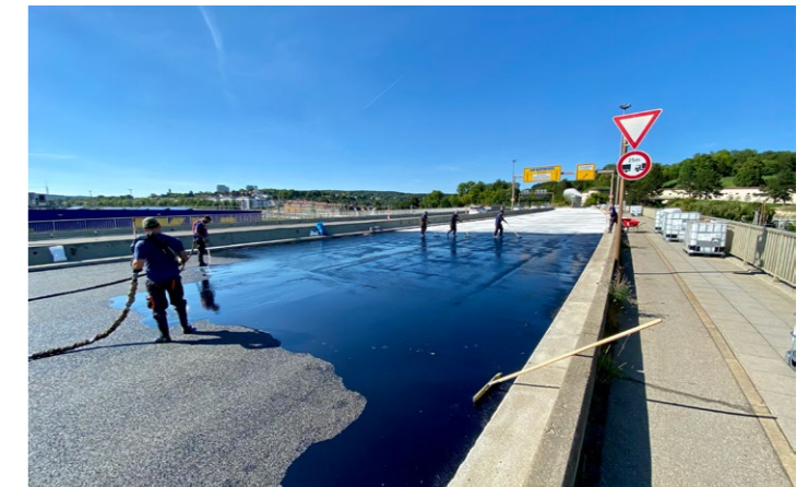
▲ HANV-Einbau Wallstraßenbrücke, Ulm
