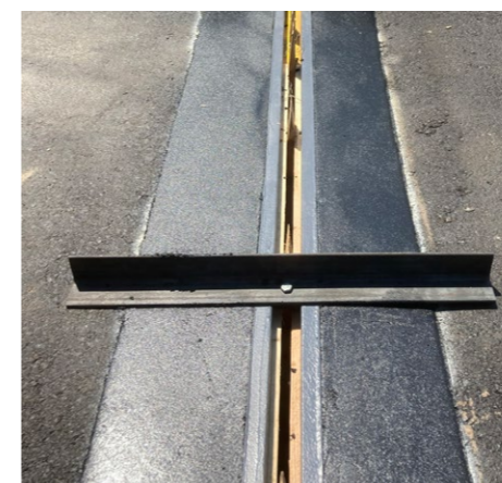
▼ Einzellige Fuge in Polymerbeton verlegt
